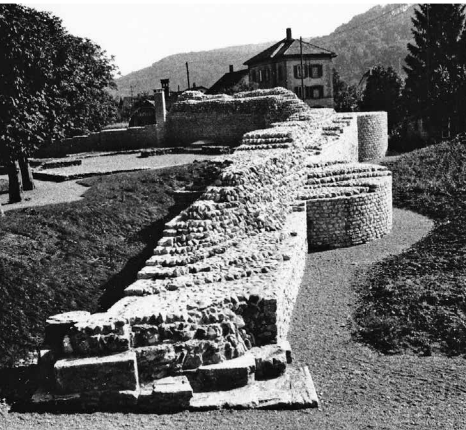
14 Die eindrücklichen Mauern des römischen Kastells, kurz nach der Restaurierung.
