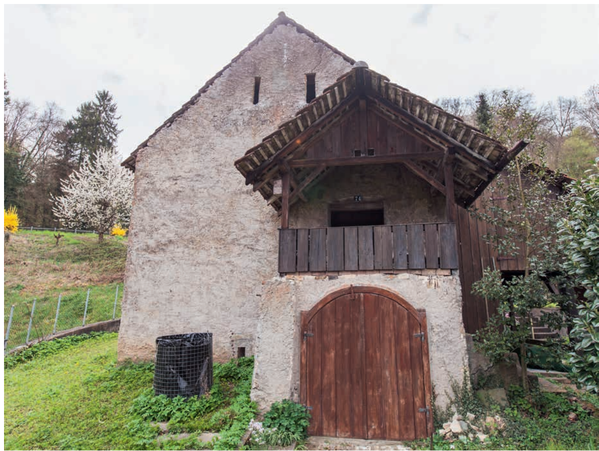
29 Rietheim-Schlossgasse 74 (Rie.015.1). Nordostseitige Giebelfassade des dreigeschossigen Steinspeichers von 1515 mit jüngerem Kellereingang und Laube. © KAAG, C. Gut.
