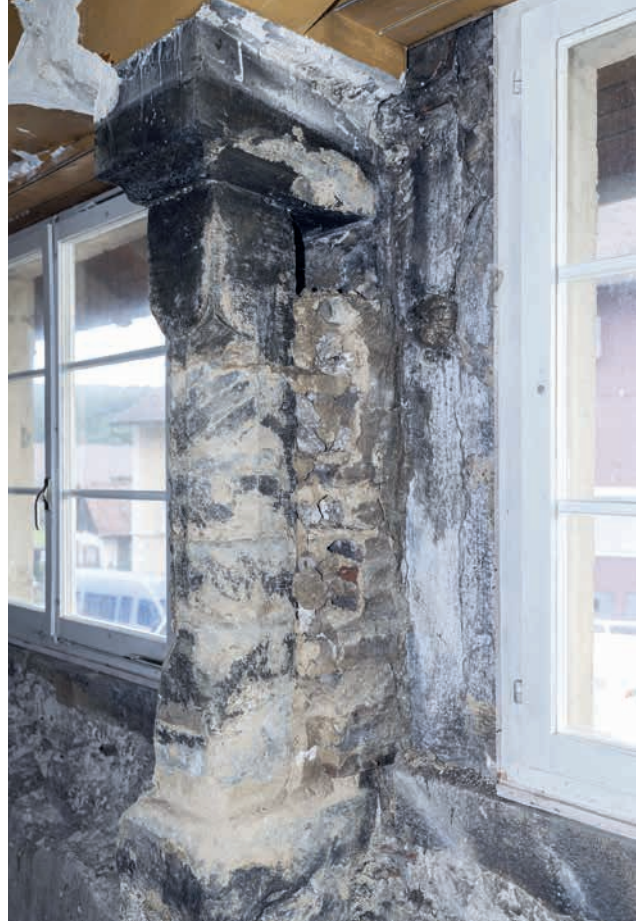
28 Rümikon-Dorfstrasse 23 (Rum.023.1). Detail der Fenstersäule einer spätgotischen Gaststube von 1577. Ansicht von Südosten. © KAAG, T. Frey.
