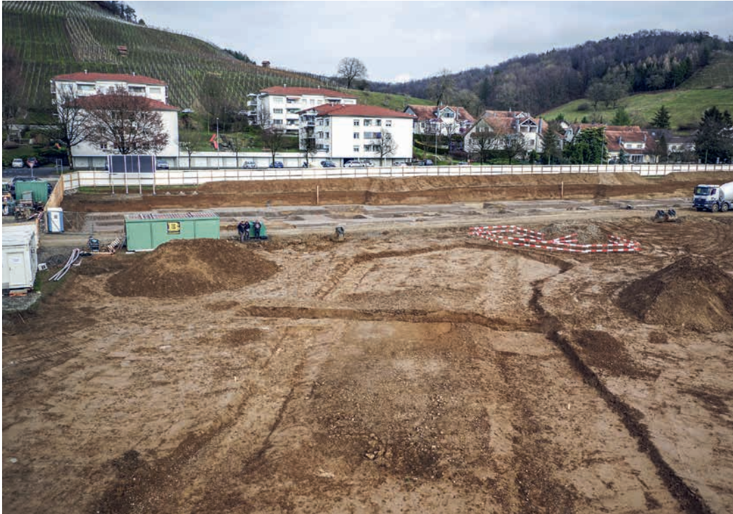
13 Döttingen-Chunte (Dtg.015.2). Drohnenaufnahme der Ausgrabungssituation mit der römischen Kiesstrasse in der Bildmitte. © KAAG, J. Piech.
