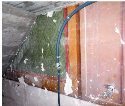
15 Aarau. Grossratssaal. Wandmalereireste von 1856 unterhalb des westlichen Podests. Links ein Wandfeld, das einen damastartigen Stoff imitiert. Rechts ein gemaltes senkrechttes Täferbrett mit Schattierung. Foto: DPAG, Edith Hunziker, 2023.
