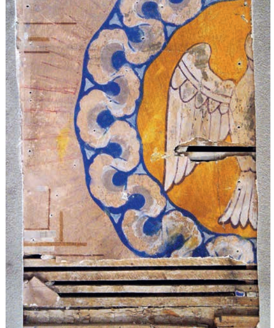
12 Leuggern. Pfarrkirche St. Peter und Paul. Befundfenster an der Chorwand mit der partiell freigelegten Heiliggeisttaube, die dann als einziges Motiv komplett freigelegt und konserviert wurde. Foto: DPAG, Stefan Buess, 2004
